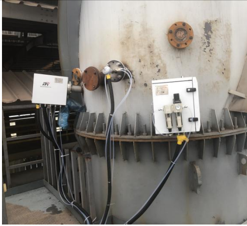
G1 排气筒采样孔
