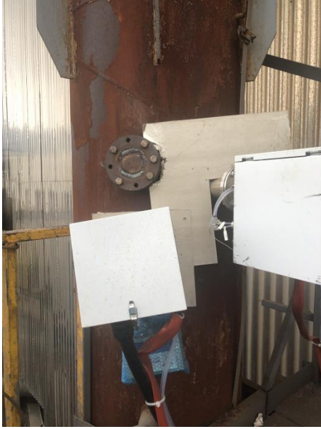
G1 排气筒采样孔
