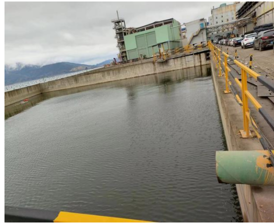
新建万方初期雨水池
