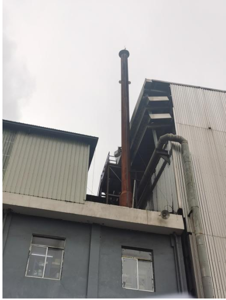
1#环形固熔炉排气筒 G1
